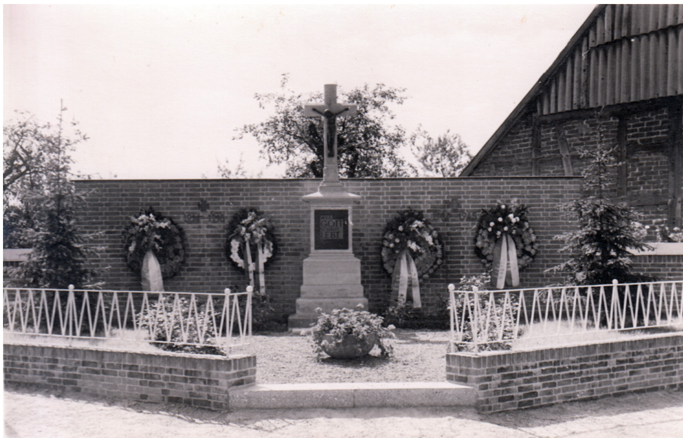
— Das Ehrenmal in Holzbüttgen nach seiner ersten Restaurierung im Jahr 1957
