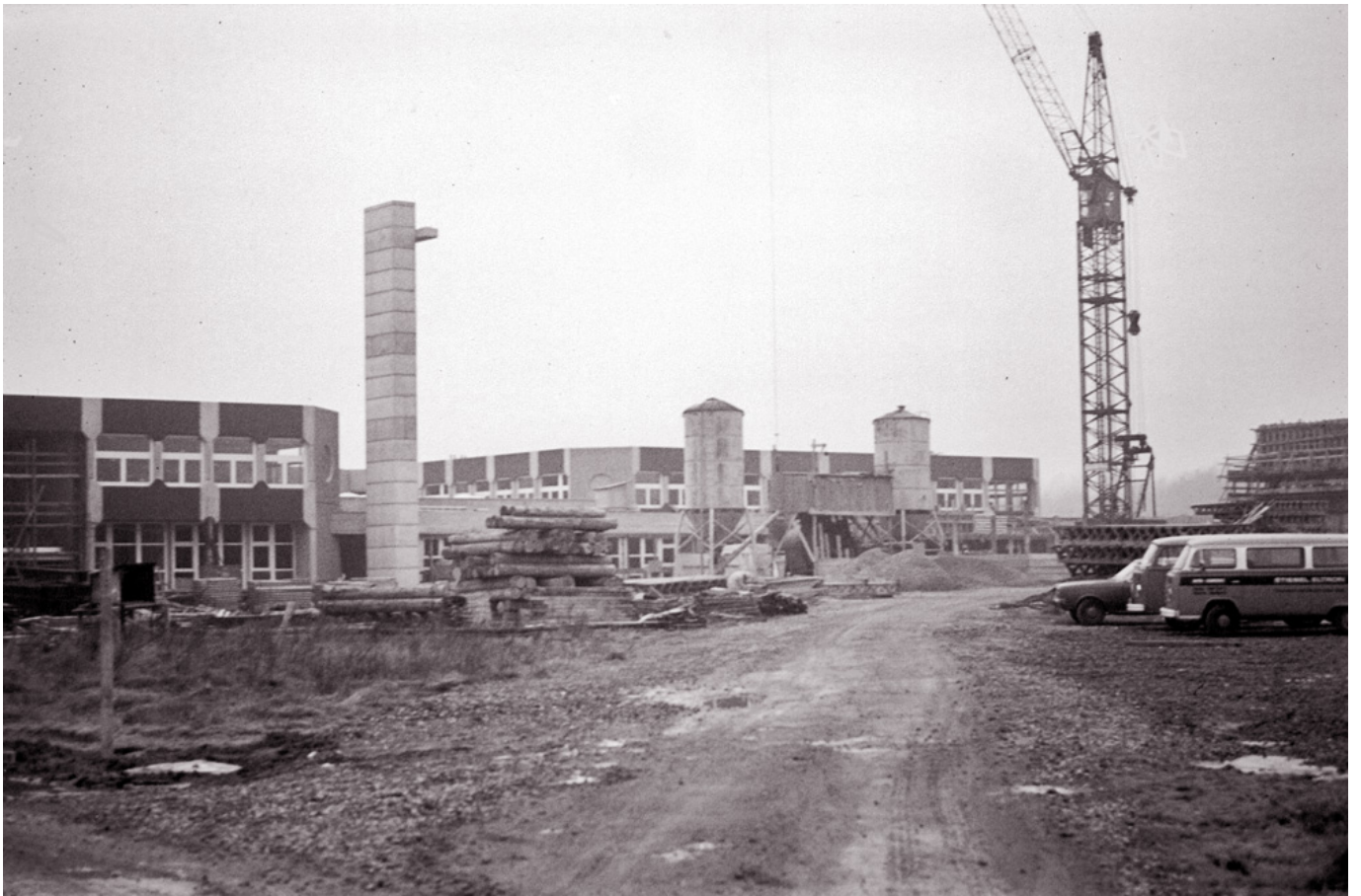
— Vorst, Am Holzbüttger Haus; 1979 wurde auf dem Areal des Holzbüttger Hauses das heutige Georg-Büchner-Gymnasium der Stadt Kaarst errichtet, hier im Rohbau
