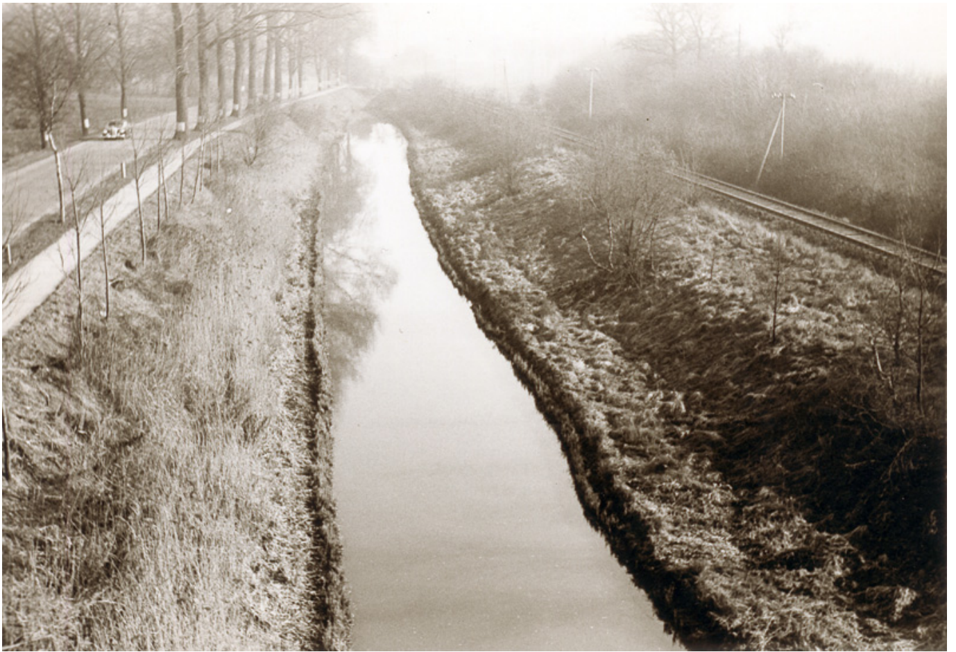
_ Der Nordkanal in den 1960er-Jahren. Links die Neersener Straße (B7) mit dem Radweg; rechts die Eisenbahnlinie Neuss-Viersen.
