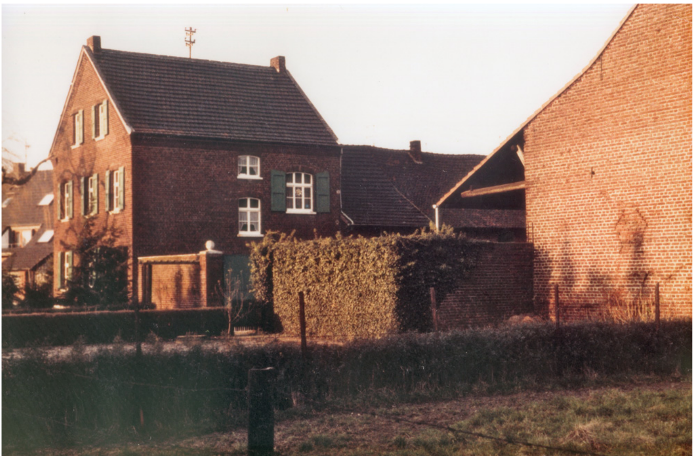
_ Der Hof von Peter Köhnen kurz vor dem Abriss im Jahr 1980
