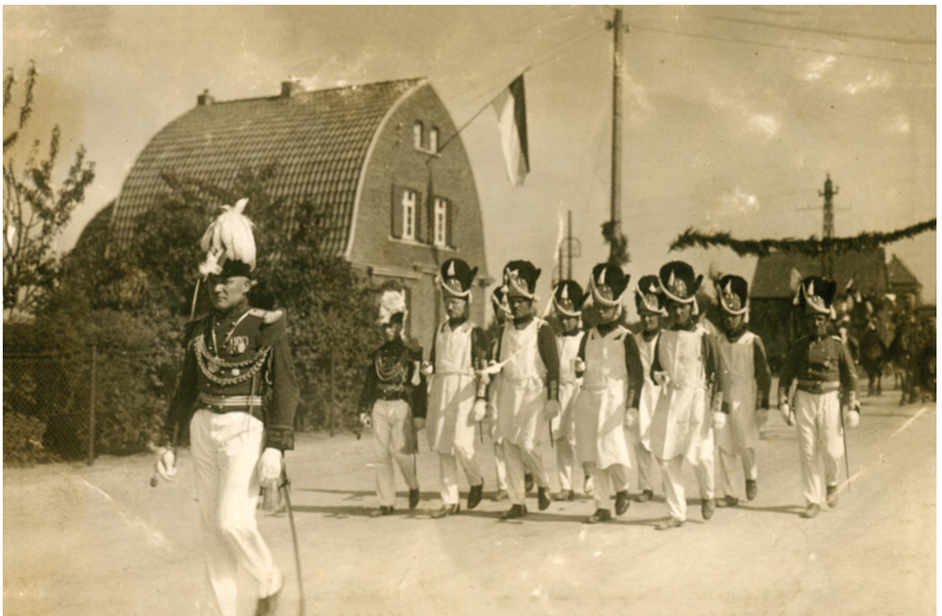
Ein Pioniercorps beim Schützenfest Anfang der 1930er Jahre vor dem Haus mit dem markanten Zollingerdach (StA Kaarst D3-3-99).
