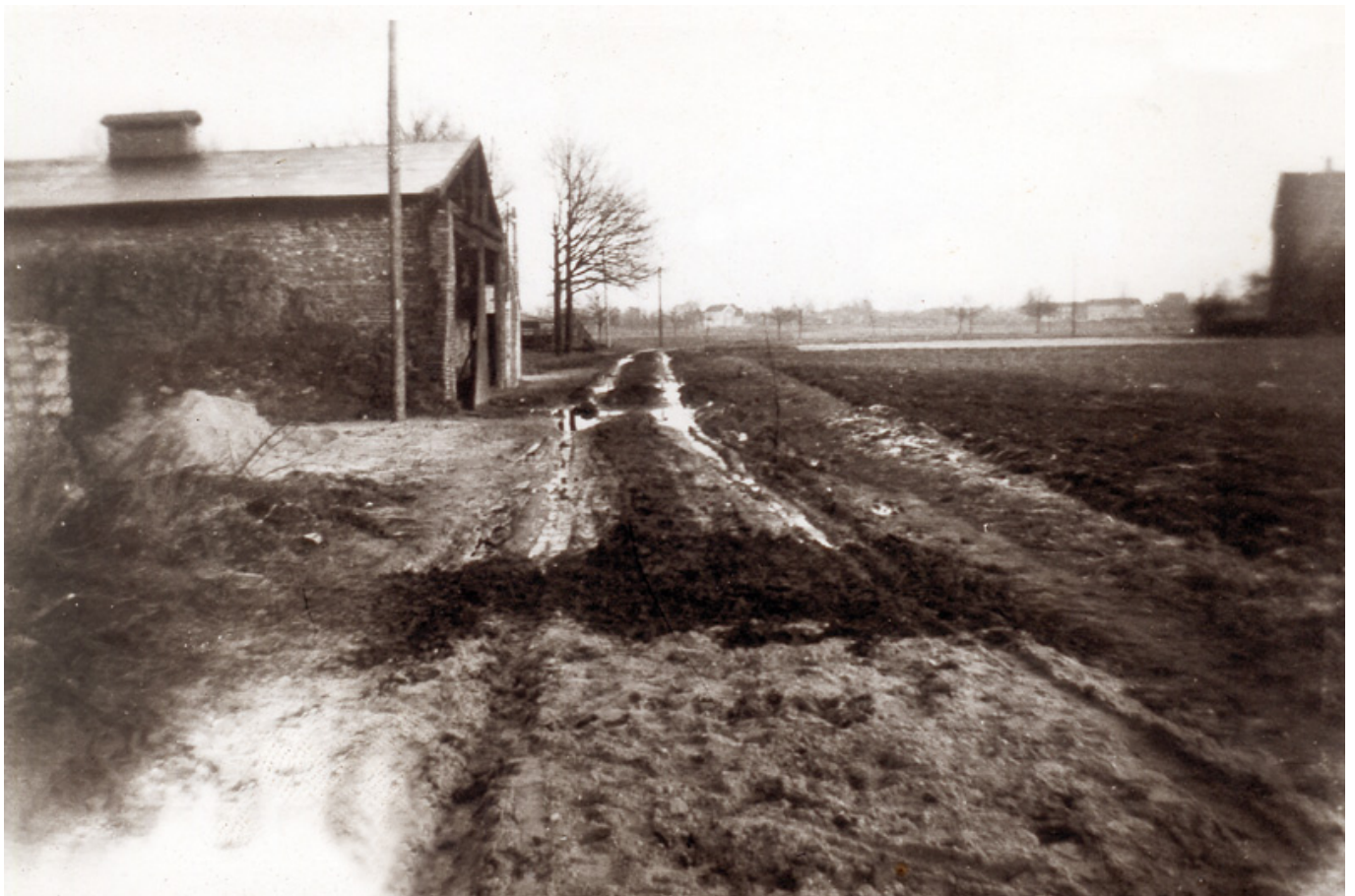
Landwirtschafts- und Baumschinentruppen der Firma Hoeveler auf der Sandstraße in Holzbüttgen im Jahr 1945. Der Schuppen wurde aus Ziegelsteinen aus der firmeneigenen Ziegelei erbaut.
